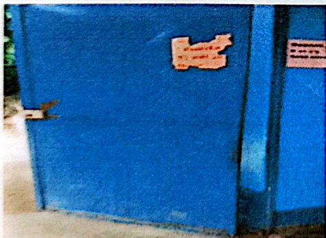
Foto 5. Sustitución de puerta metálica con chapa yale
