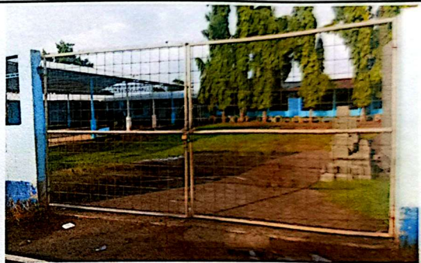
Foto 4. Sustitución de portón metálico con chapa yale y puerta central
