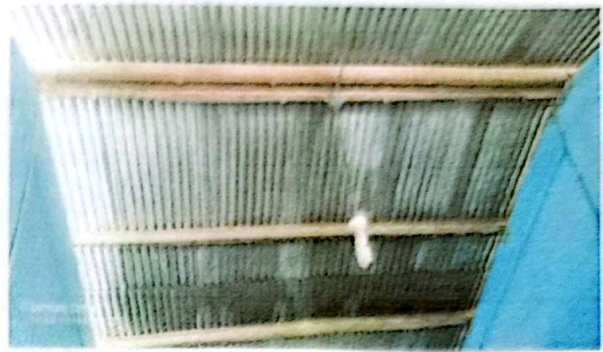
Foto 2. Sustitución de estructura de metal por metal galvanizado chapa 16
