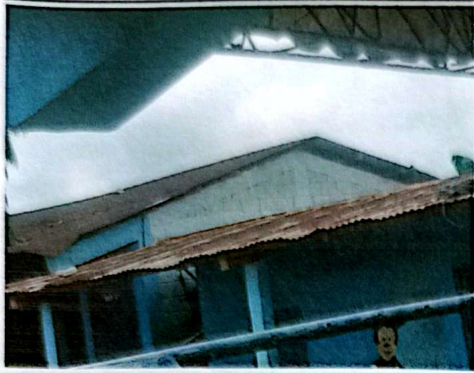
Foto 1. Sustitución de cubierta de lámina acanalada por lámina troquelada aluzinc calibre 26
