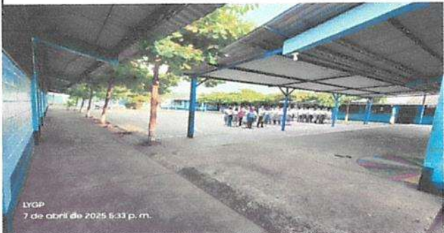
MANTENIMIENTO CORRECTIVO A ESTRUCTURA PORTANTE DE METAL Y CUBIERTA DE LÁMINA
