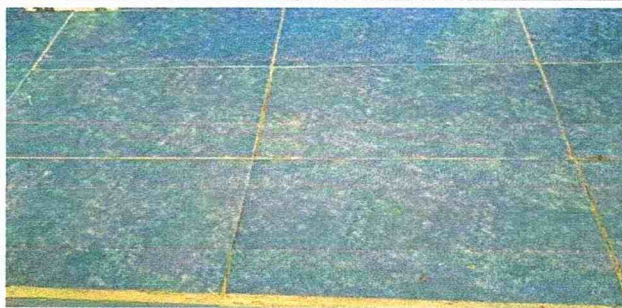
Foto 3: Sustitución de mesas de trabajo en cocina incluye azulejo
