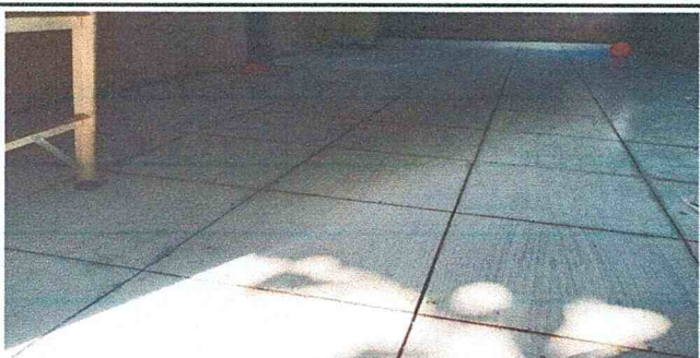
Foto 9: Sustrución de piso de concreto, por cerámico
