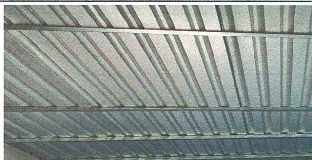
Foto 7: Sustrución de lámina, por lámina troquelada cal.26
