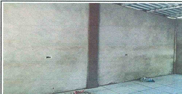
Foto 8: Repello gris en muro
