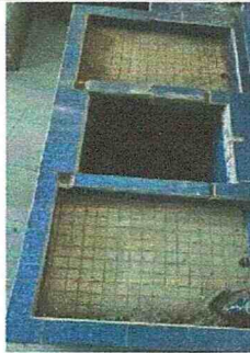
Foto 1: Mantenimiento correctivo a pila de concreto de 3 lavaderos + azulejo
