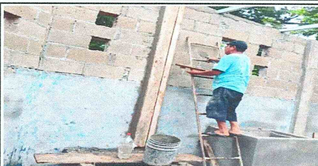
Foto 8: Repello gris en muro
