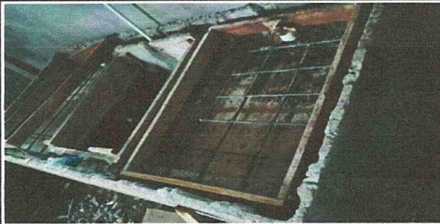
Foto 1: Mantenimiento correctivo a pila de concreto de 3 lavaderos + azulejo
