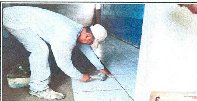
Foto 9: Sustitución de piso de concreto, por cerámico
