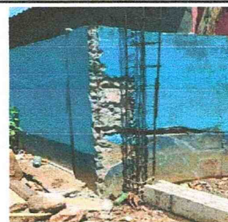
Foto 4: Reparación de muro con columnas 0.20m x 0.20m
