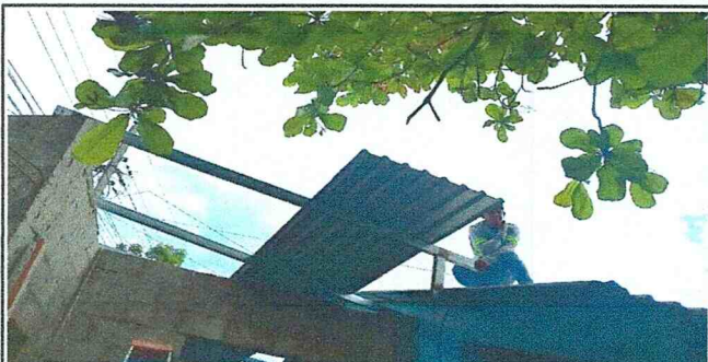
Foto 7: Sustitución de lámina, por lámina troquelada cal.26
