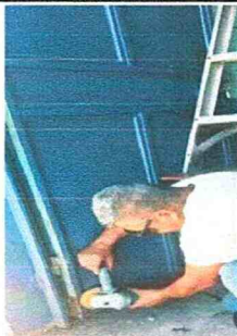
Foto 5: Sustitución de puerta de metal
