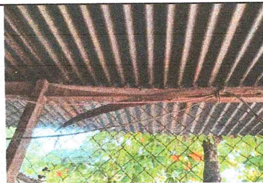
Foto No. 6 Sustitución de estructura de soporte de madera, por metal
