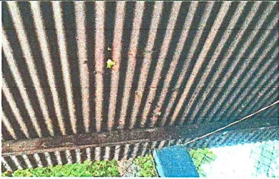
Foto No. 7 Sustitución de lámina, por lámina troquelada cal.26
