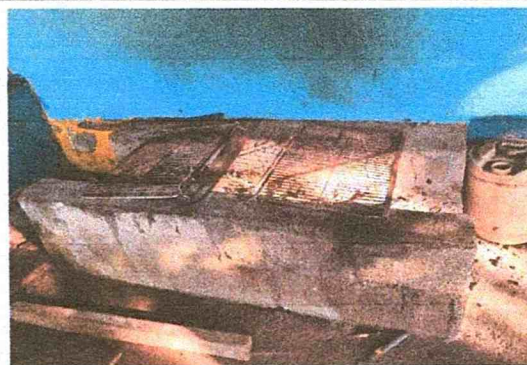
Foto No. 2 Sustitución de estufa rural (completa) incluye 2 parrillas de hierro
