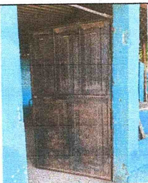
Foto No. 5 Sustitución de puerta de metal
