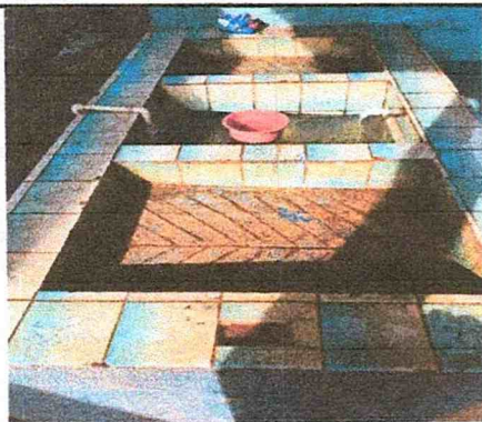
Foto No. 1 Mantenimiento correctivo a pila de concreto de 3 lavaderos + azulejo
