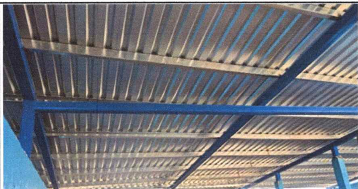
Foto 3: Sustitución de lámina, por lámina troquelada cal. 26
