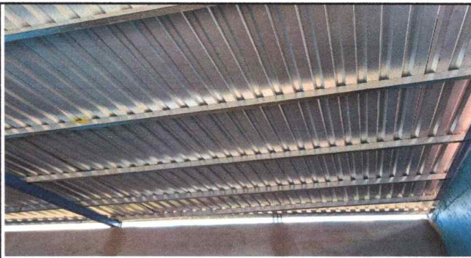
Foto 4: Sustitución de lámina, por lámina troquelada cal. 26
