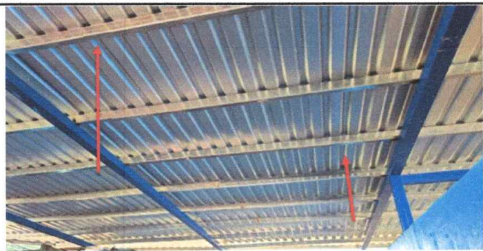
Foto 5: Sustitución de estructura de soporte (madera) por metal
