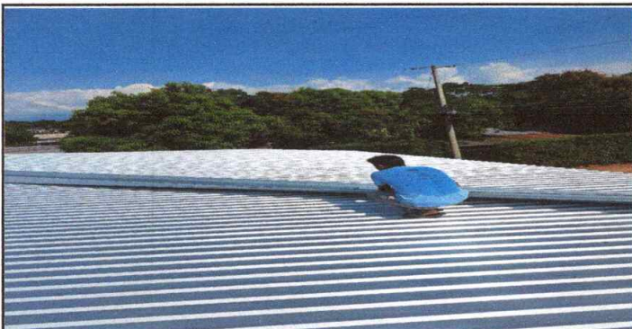
Foto 3: Sustitución de lámina, por lámina troquelada cal. 26
