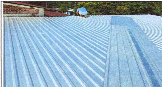
Foto 4: Sustitución de lámina, por lámina troquelada cal. 26
