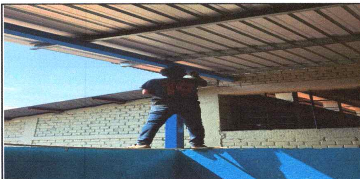
Foto 5: Sustitución de estructura de soporte (madera) por metal
