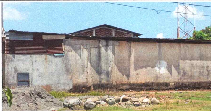
Foto 1: Reparación de muro con Columnas 0.20x0.20x4.0m 4 Hierro 1/2 y estribos
