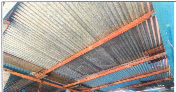
Foto 3: Sustitución de lámina , por lamina troqueleada cal. 26
