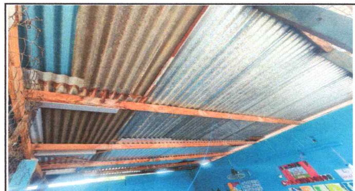
Foto 4: Sustitución de lámina , por lamina troqueleada cal. 26
