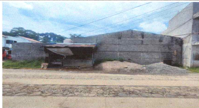
Foto 2: Reparación de Muro con Block 50Kg7cm2 14x19x39 cm
