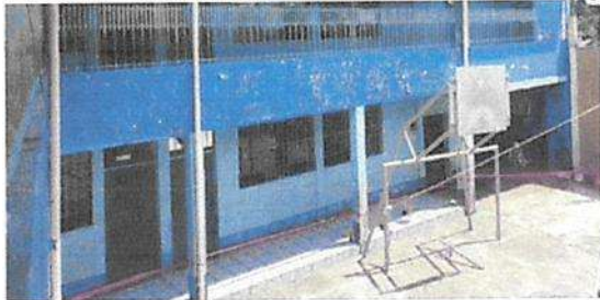
Mantenimiento de piso de cancha con mortero estructural de reparación en baches en 266 m2 de resane
