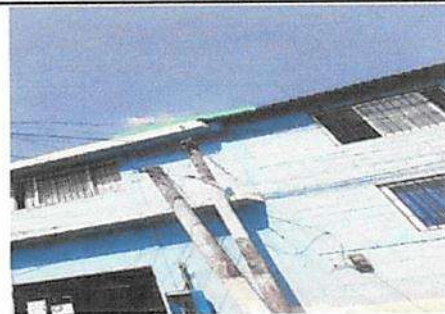
Mantenimiento de techo de fachada con bajada pluvial y canal en techo de fachada, Mantenimiento de muro de fachada con pintura latex celeste y blanco
