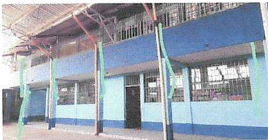
Mantenimiento de techo de cancha con bajadas pluviales
