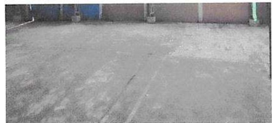
Mantenimiento de piso de cancha con pintura epoxica colores
