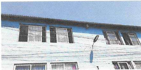
Mantenimiento de techo voladizo en fachada 1m x 15m lamina troquelada Calibre 26 y estructura soporte metálica del voladizo, Mantenimiento de estructura metálica de balcones de fachada y portón de ingreso con pintura anticorrosiva secado rapido
