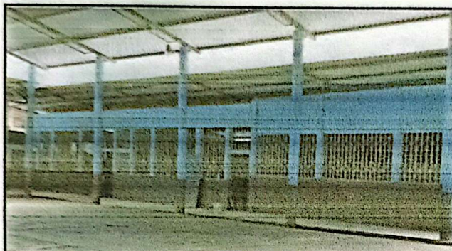
Foto 3. Sustitución de cubierta de lámina por lámina troquelada calibre 26. Lado Norte sobre la 6a. Calle: Aulas de 1o. A, 6o. A y 4o. C. Corredor e interior de las aulas en mención.
