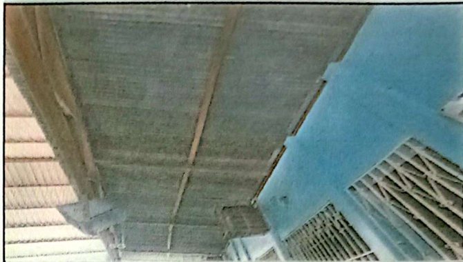
Foto 2. Mantenimiento de estructura con soporte de metal con anticorrosivo. Lado Oeste sobre la 0 Avenida de la Zona 1: Aulas de Párvulos Etapa 6 B y 1o. C. Corredor e interior de las aulas en mención.
