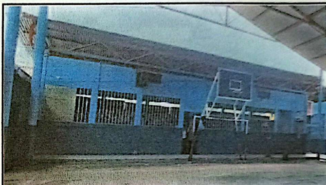
Foto 4. Sustitución de cubierta de lámina por lámina troquelada calibre 26. Lado Oeste sobre la 0 Avenida de la Zona 1: Aulas de Párvulos Etapa 6 B y 1o. C. Corredor e interior de las aulas en mención.
