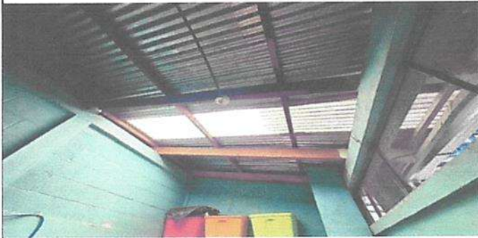
SUMINISTRO E INSTALACIÓN DE ESTRUCTURA PORTANTE DE METAL GALVANIZADO CHAPA 16
