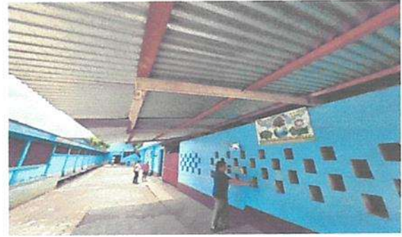
SUMINISTRO E INSTALACIÓN DE CUBIERTA DE LAMINA POR LAMINA TROQUELADA CALIBRE 26 ALUZINC
