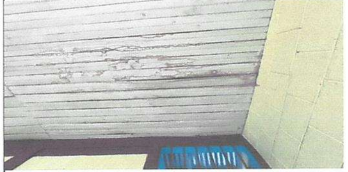
SUMINISTRO E INSTALACIÓN DE CIELO FALSO
