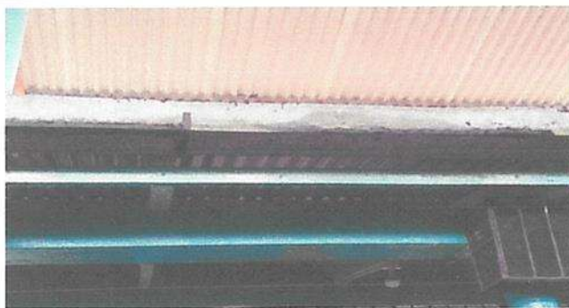
SUMINISTRO DE CANAL PLUVIAL CON LAMINA LISA CALIBRE 26
