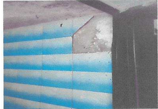
Foto 2: REPARACIÓN Y SUSTITUCIÓN DE AZULEJO CERAMICO
