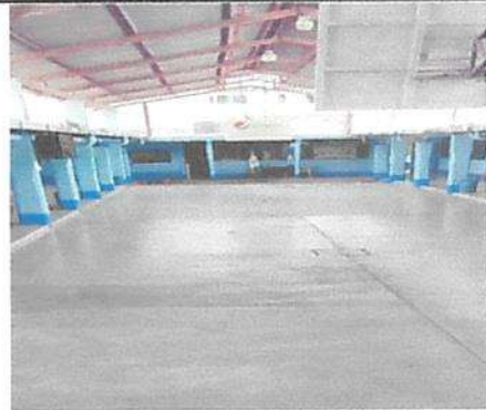
Foto 4: REPARACIÓN Y SUSTITUCIÓN DE PISO
