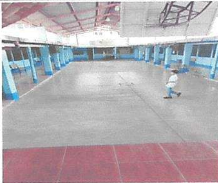
Foto 3: REPARACIÓN Y SUSTITUCIÓN DE PISO
