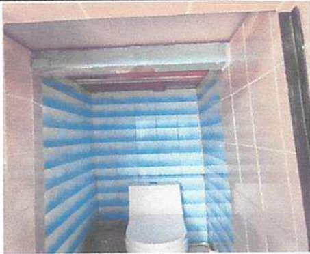
Foto 1: REPARACIÓN Y SUSTITUCIÓN DE AZULEJO CERAMICO
