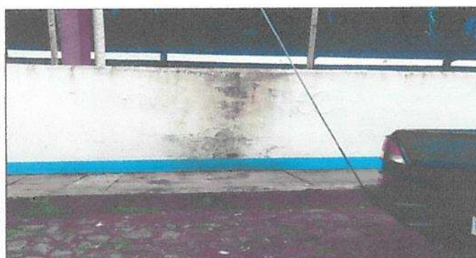
Suministro y aplicación de pintura interior o exterior celeste para muro
