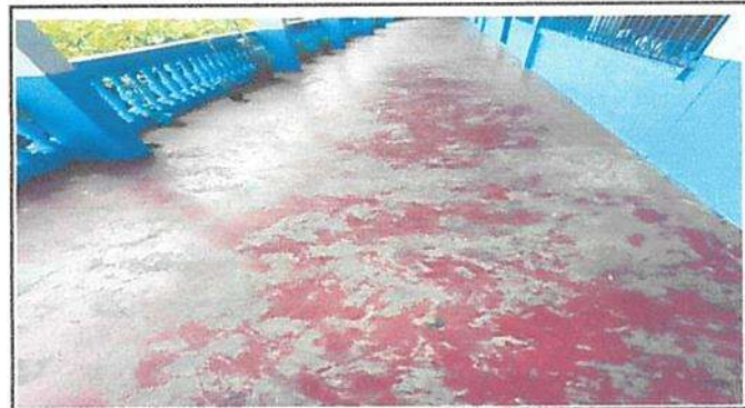
Sustitución de torta de cemento por cerámico
