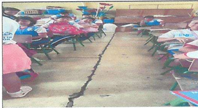
Sustitución de torta de cemento por cerámico
