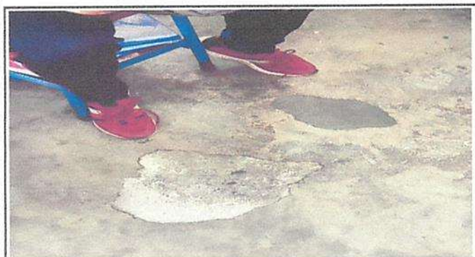
Sustitución de torta de cemento por cerámico
