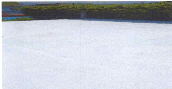
FOTO 1: Reparación de losa con impermeabilizante de acrílico 6 años (67 metros cuadrados)
