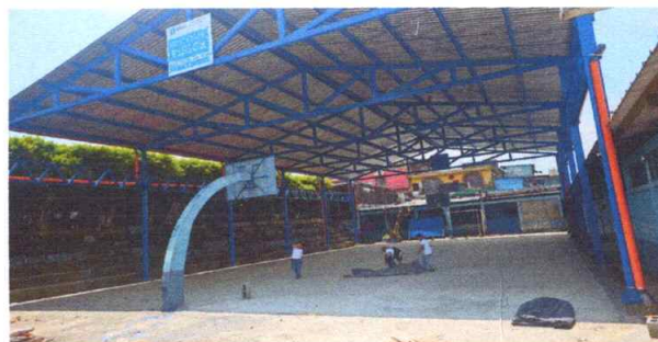
FOTO 2: Mantenimiento de piso de cancha deportiva (548 metros cuadrados)
