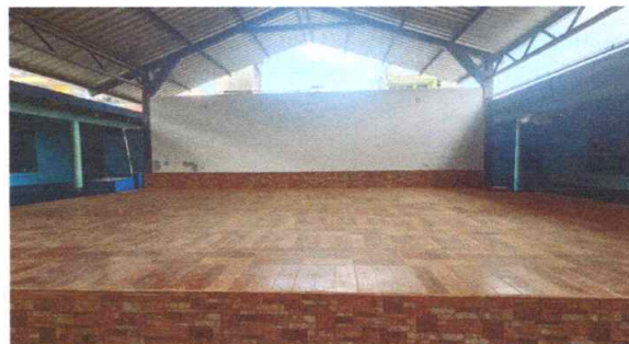
FOTO 4: Sustitución de piso de torta de concreto, por cerámico antideslizante (PISO 59 metros cuadrados)
