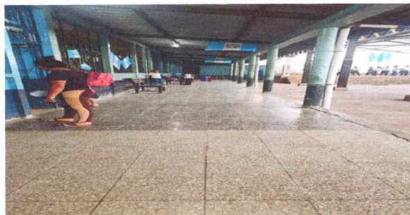
FOTO 3: Sustitución de piso por piso granito, + acabado pulido (193 metros cuadrados)
