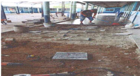
FOTO 3: Sustitución de piso por piso granito, + acabado pulido (193 metros cuadrados)
