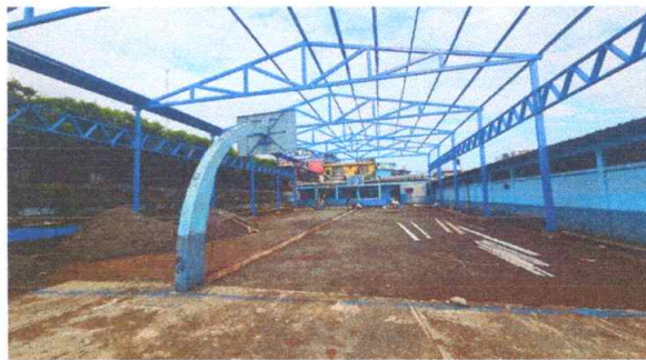
FOTO 2: Mantenimiento de piso de cancha deportiva (548 metros cuadrados)
