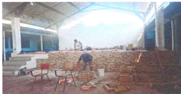
FOTO 4: Sustitución de piso de torta de concreto, por cerámico antideslizante ( PISO 59 metros cuadrados)
