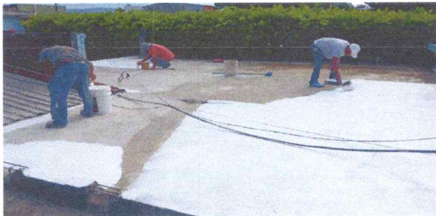
FOTO 1: Reparación de losa con impermeabilizante de acrílico 6 años ( 67 Metros cuadrados)
