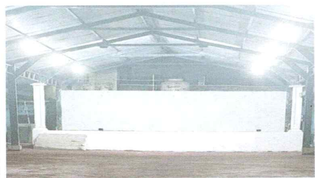
FOTO 4. Sustitución de piso de torta de concreto, por cerámico antideslizante
