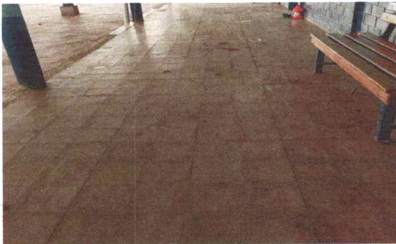
FOTO 3. Sustitución de piso por piso granito, + acabado pulido
