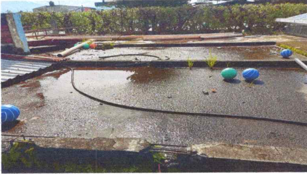
FOTO 1. Reparación de losa con impermeabilizante de acrílico 6 años
