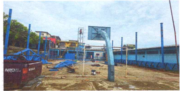
FOTO 2. Mantenimiento de piso de cancha deportiva con suministro y aplicación de pintura epoxica colores (limpieza, resane y aplicación)
