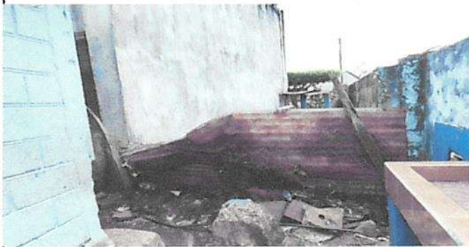
Mantenimiento correctivo con sustitución de cerco perimetral metalico por barda pre-fabricada.
