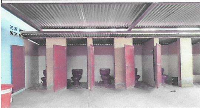
sustitucion de inodoro elongado
