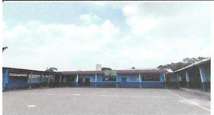
Sustitución de lamina por lamina troquelada calibre 26
