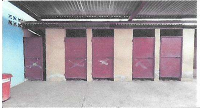
sustitución de puerta de servicios sanitarios metálica
