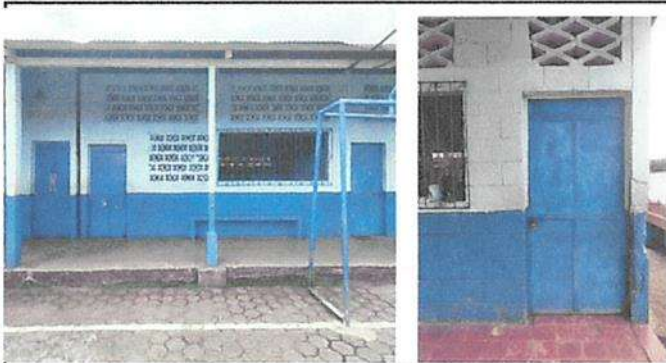
Sustitución de puerta metálica
