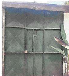
2. Sustitución de portón metálico abatible 3 hojas, por portón metálico dos hojas.
