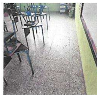
4. Sustitución de piso de granito, por piso cerámico.
