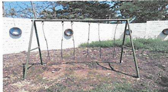
7. Mantenimeinto correctivo a juegos infantiles metálicos
