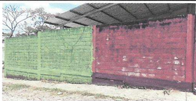
5. Reparación de muro perimetral existente de block. (Repello)
