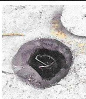
6. Sustitución de cableado eléctrico calibre 12 awg.
