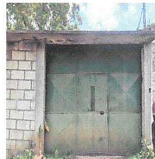
2. Sustitución de portón metálico abatible 3 hojas, por portón metálico dos hojas.
