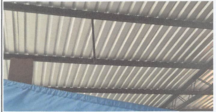
Foto No.8: Sustitución de lámina por lámina troquelada calibre 26
