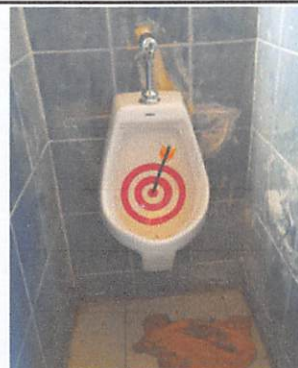
Foto No.4: Sustrucción Mingitorio
