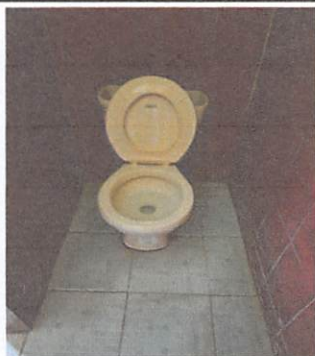
Foto No.5: Sustrucción Inodoro elongado
