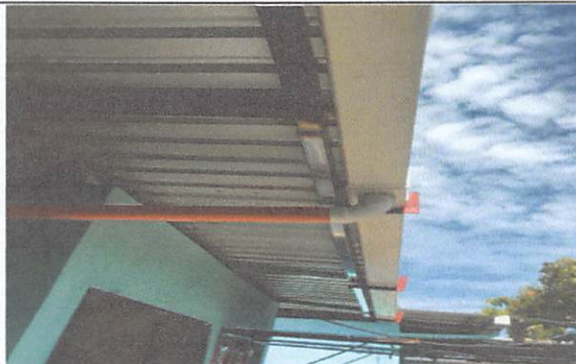
Foto No.2: Sustrucción de canal de Pvc a Metal.
