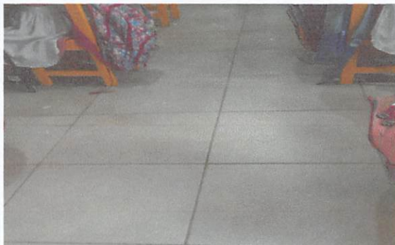
Foto No.1: Sustrucción de piso de concreto a piso cerámico.
