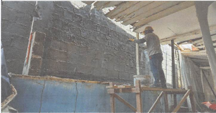
Foto No.7: Repello de muro
