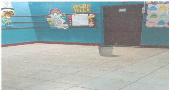
Foto No.1: Sustitución de piso de concreto a piso cerámico.
