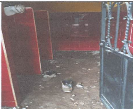
Foto No.5: Sustitución inodoro elongado
