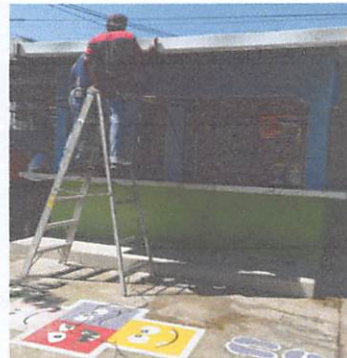
Foto No.2: Sustución de canal de Pvc a Metal.
