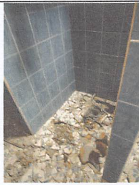
Foto No.4: Sustitución Mingitorio
