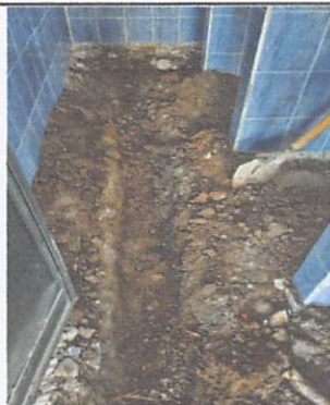
Foto No.3: Sustitución de tubería de concreto a Pvc línea principal aguas negras.
