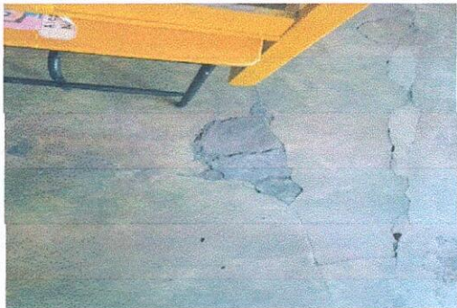
Foto No.1: Sustitución de piso de concreto a piso cerámico.
