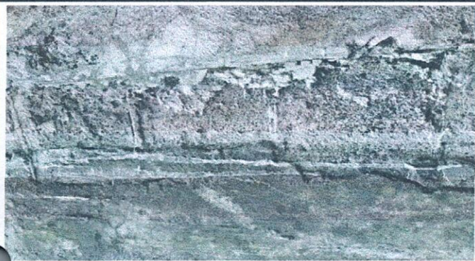
Foto No.7: Repello de muro
