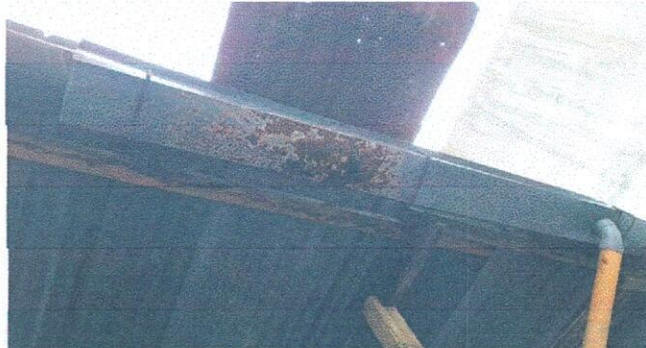
Foto No.2: Sustitución de canal de Pvc a Metal.
