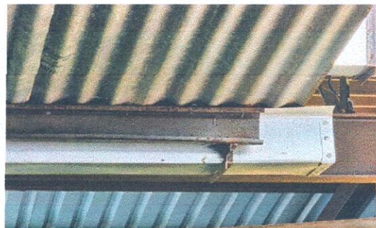
Foto No.8: Sustitución de lámina por lámina troquelada calibre 26
