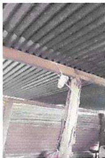
SUSTITUCIÓN DE CUBIERTA METALICA EN COCINA
