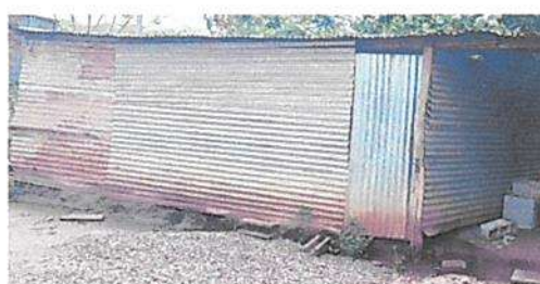
SUSTITUCIÓN DE PUERTA DE COCINA
