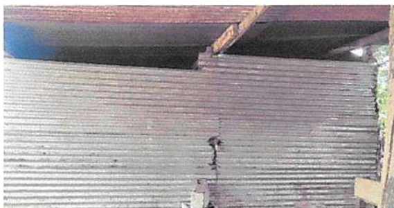
SUSTITUCIÓN DE LAMINA ACANALADA A TROQUELADA EN MUROS DE COCINA
