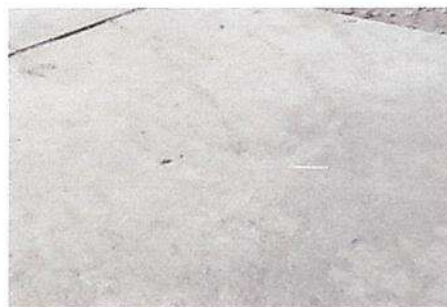
REPARACIÓN DE FIRME DE CONCRETO DE 7 CM CON ACABADO GRIS NATURAL
