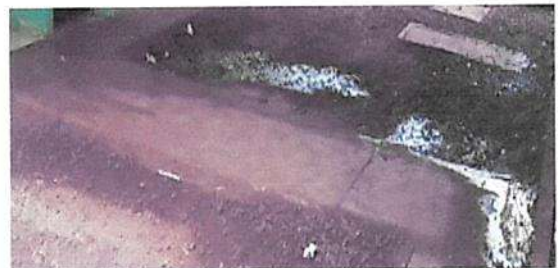
SUSTITUCIÓN DE TORTA DE CONCRETO CON ESPESOR DE 7 CM
