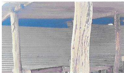
SUSTITUCIÓN DE ESTRUCTURA PORTANTE A ESTRUCTURA METALICA
