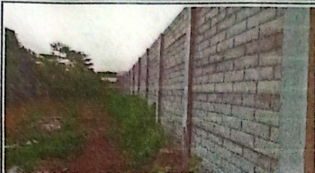
1. SUSTITUCION DE MURO PERIMETRAL CON BARRA PREFABRICADA DE CONCRETO H=2.50 METROS, CONCRETO REFORZADO 2.5m x 45m Total 112.5 METROS CUADRADOS
