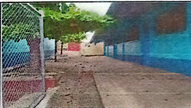
SUMINISTRO Y APLICACIÓN DE PINTURA EXTERIOR MARCA CORONA, 300 METROS CUADRADOS
