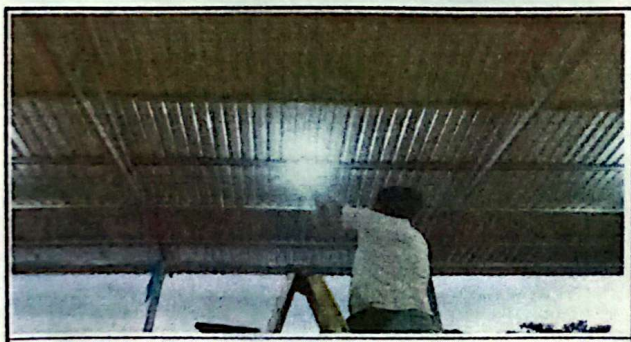
SUSTITUCION DE BOMBILLO LED GLOBO 30W, 10 BOMBILLOS
