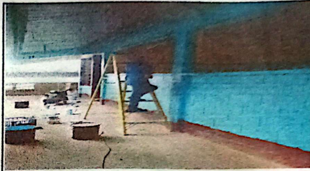
SUMINISTRO Y APLICACIÓN DE PINTURA EXTERIOR MARCA CORONA, 300 METROS CUADRADOS
