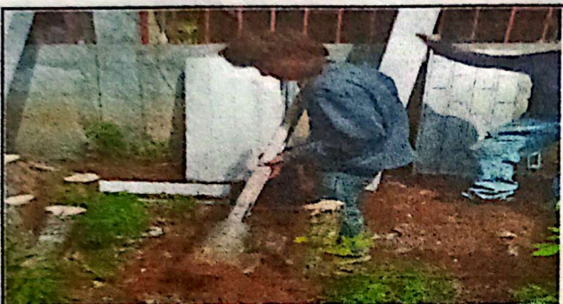
SUSTITUCION DE PUERTA METALICA 1X2 METROS, 1 PUERTA
