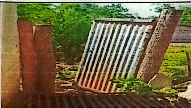
SUSTITUCION DE PUERTA METALICA 1X2 METROS, 1 PUERTA
