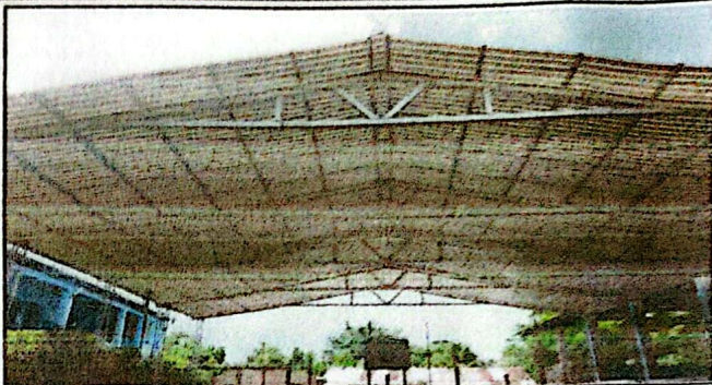
Foto #2: Sustitución de techo o cubierta de lámina. 272 metros cuadrados
