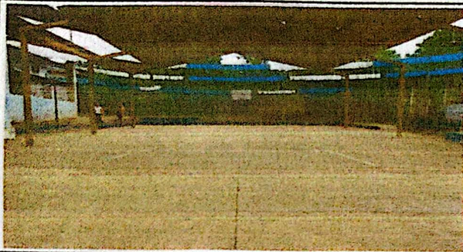
Foto #1: Sustitución de estructura metálica. 272 metros cuadrados
