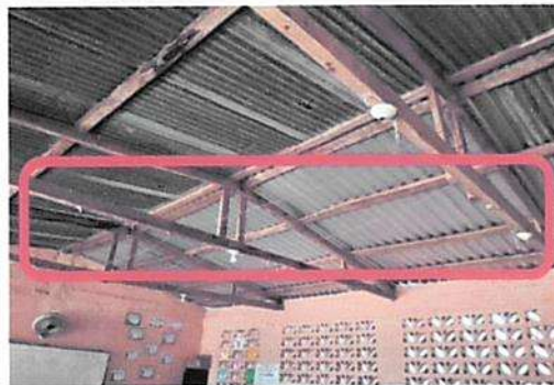
Reparación del sistema eléctrico de las aulas y corredores 5 y 6.
