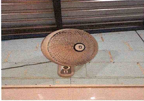
SUSTITUCION DE VENTILADORES DE 16" MARCA NAVIA
