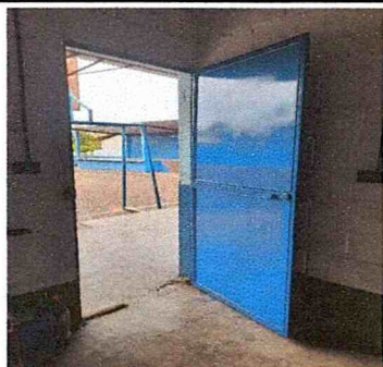
SUSTITUCION DE PUERTA METALICA CON CHAPA YALE
