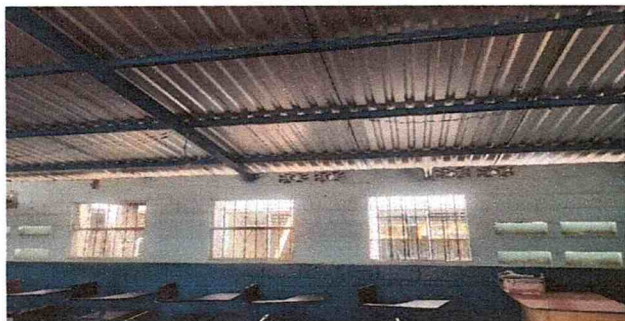
SUMINISTRO E INSTALACION DE CUBIERTA DE LAMINA POR LAMINA TROQUELADA CALIBRE 26 ALUZINC
