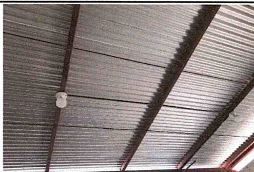
REPARACIÓN DE CABLEADO ELÉCTRICO CALIBRE 10 AWG
