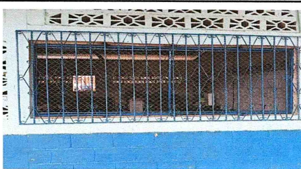
SUSTITUCION DE ESTRUCTURA DE METAL VENTANA
