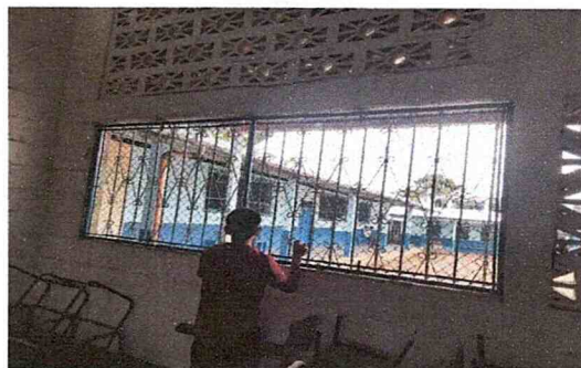
SUSTITUCION DE ESTRUCTURA DE METAL VENTANA
