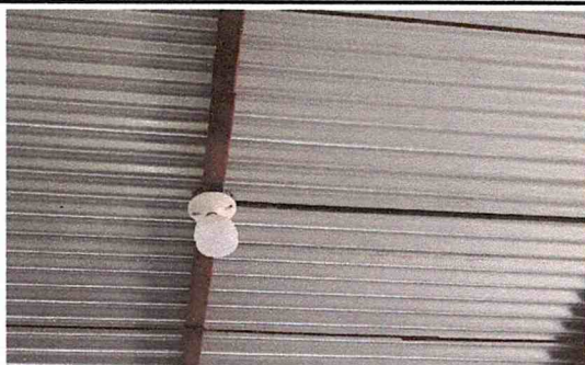
REPARACIÓN DE CABLEADO ELÉCTRICO CALIBRE 10 AWG
