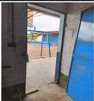
SUSTITUCION DE PUERTA METALICA CON CHAPA YALE
