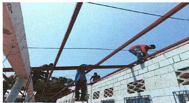
MANTENIMIENTO A ESTRUCTURA DE SOPORTE DE METAL ANTICORROSIVO
