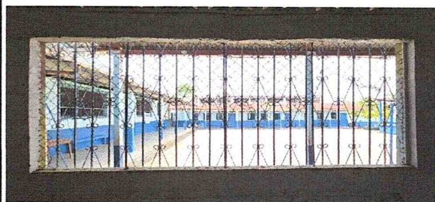
SUSTITUCION DE ESTRUCTURA DE METAL VENTANA
