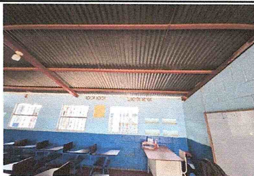
MANTENIMIENTO A ESTRUCTURA DE SOPORTE DE METAL ANTICORROSIVO
