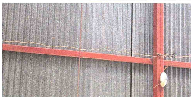
REPARACIÓN DE CABLEADO ELÉCTRICO CALIBRE 10 AWG
