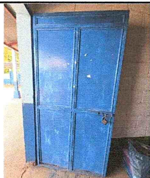
SUSTITUCION DE PUERTA METALICA CON CHAPA YALE
