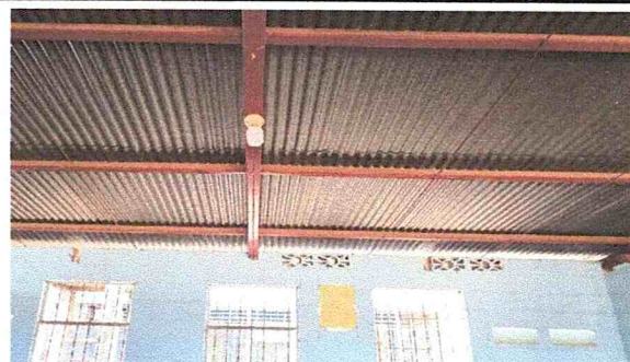
SUSTITUCIÓN DE LÁMPARAS BOMBILLO LED SYLVANIA 30W
