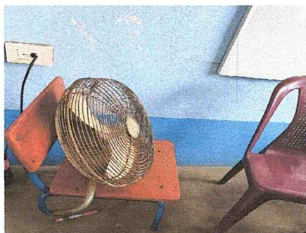
SUSTITUCION DE VENTILADORES DE 16" MARCA NAVIA
