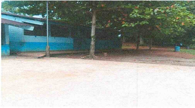
Foto No. 1 REPARACIÓN/SUSTITUCIÓN DE PISO DE TORTA DE CONCRETO. 540 metros cuadrados.
