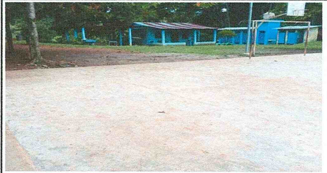
Foto No. 2 REPARACIÓN/SUSTITUCIÓN DE PISO DE TORTA DE CONCRETO. 540 metros cuadrados.
