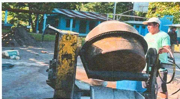
Foto No. 3 REPARACIÓN/SUSTITUCIÓN DE PISO DE TORTA DE CONCRETO. 540 metros cuadrados.
