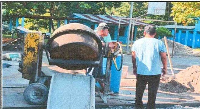
Foto No. 2 REPARACIÓN/SUSTITUCIÓN DE PISO DE TORTA DE CONCRETO. 540 metros cuadrados.
