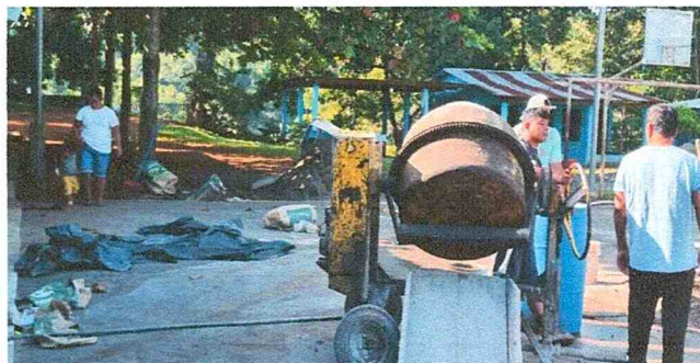
Foto No. 4 REPARACIÓN/SUSTITUCIÓN DE PISO DE TORTA DE CONCRETO. 540 metros cuadrados.
