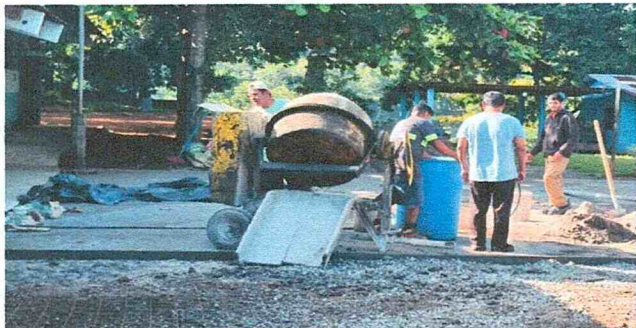
Foto No. 1 REPARACIÓN/SUSTITUCIÓN DE PISO DE TORTA DE CONCRETO. 540 metros cuadrados.
