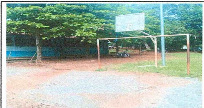
Foto No. 3 REPARACIÓN/SUSTITUCIÓN DE PISO DE TORTA DE CONCRETO. 540 metros cuadrados.
