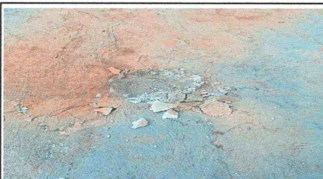
Foto No. 4 REPARACIÓN/SUSTITUCIÓN DE PISO DE TORTA DE CONCRETO. 540 metros cuadrados.
