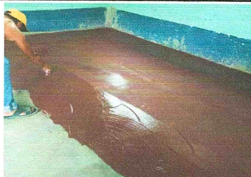
SUSTITUCION DE TORTA DE CONCRETO POR PISO LISO
