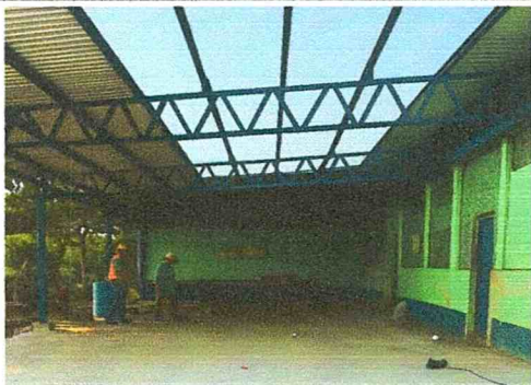
SUSTITUCION DE LAMINA POR LAMINA TROQUELADA CALIBRE 26 ALUZINC
