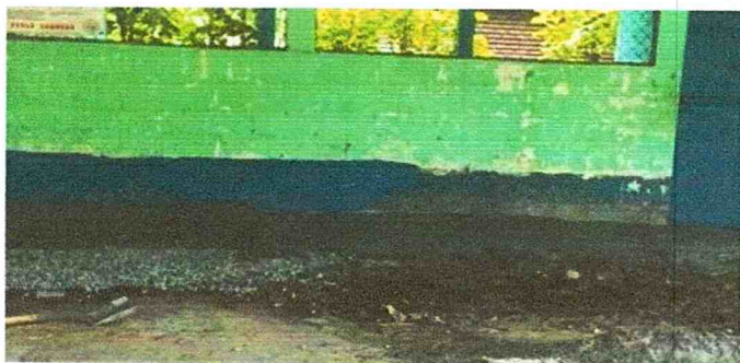
SUSTITUCION DE PISO DE TORTA DE CONCRETO
