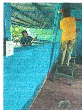
SUMINISTRO Y APLICACIÓN DE PINTURA INTERIOR MARCA CORONA
