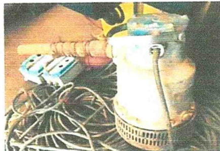
SUSTITUCION DE BOMBA SUMERGIBLE 1/2 HP USO RUDO, TRUPER. ALTURA MAXIMA 18 M, 97 LPM
