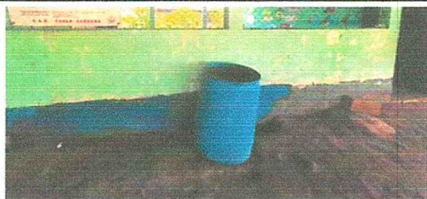
SUSTITUCION DE PISO DE TORTA DE CONCRETO
