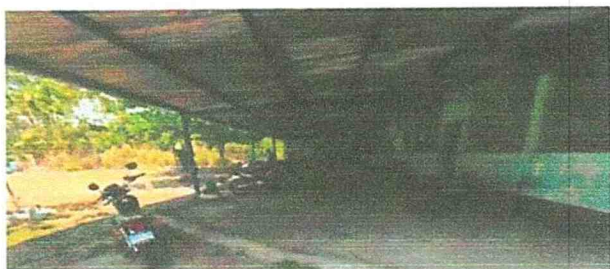
SUSTITUCION DE LAMINA POR LAMINA TROQUELADA CALIBRE 26 ALUZINC
