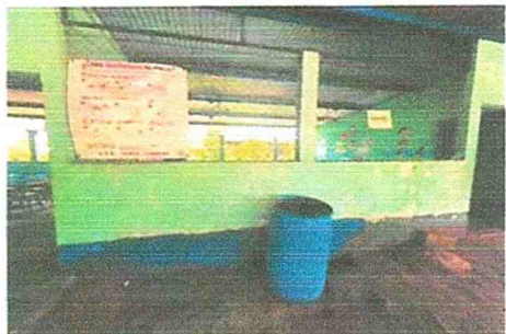
SUMINISTRO Y APLICACIÓN DE PINTURA EXTERIOR MARCA CORONA
