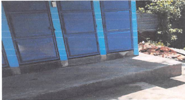
Foto #1: REPARACIÓN Y SUSTITUCIÓN DE PISO DE CONCRETO
