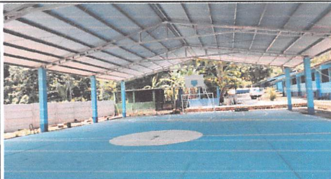
Foto #10: MANTENIMIENTO DE PISO DE CANCHA DEPORTIVA CON SUMINISTRO Y APLICACIÓN DE PINTURA EPÓXICA
