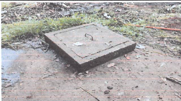
Foto #11: LIMPIEZA Y MANTENIMIENTO DE FOSA SÉPTICA
