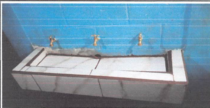
Foto #5: MANTENIMIENTO LAVADEROS DE CONCRETO
