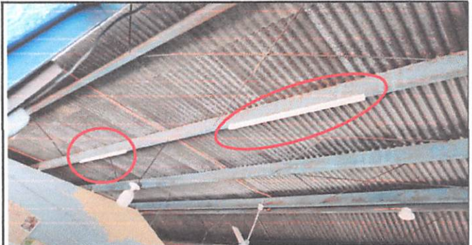
Foto #2: SUSTITUCIÓN DEL SISTEMA ELÉCTRICO
