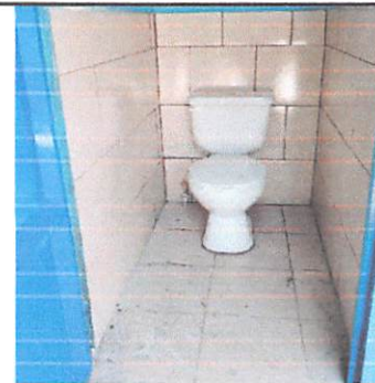
Foto #6: SUSTITUCIÓN DE PISO DE CONCRETO, POR CERÁMICO
