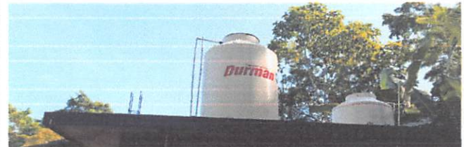
Foto #4: MANTENIMIENTO DE DEPÓSITO DE AGUA INCLUYE ACCESORIOS
