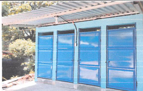
Foto #8: SUSTITUCIÓN DE LÁMINA, POR LÁMINA TROQUELADA CAL.26
