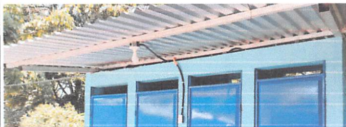
Foto #9: MANTENIMIENTO A ESTRUCTURA DE SOPORTE DE METAL CON ANTICORROSIVO
