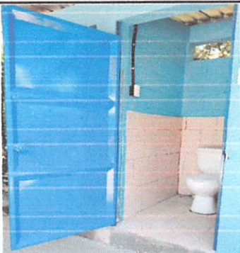
Foto #7: MANTENIMIENTO DE PUERTAS DE METAL
