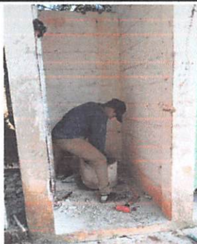
Foto #3: SUSTITUCIÓN DE SANITARIOS
