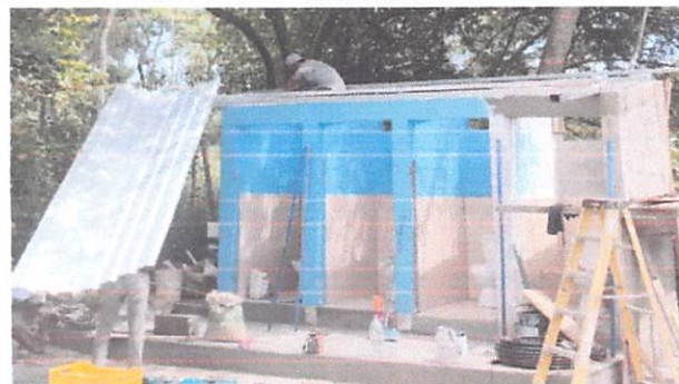
Foto #8: SUSTITUCIÓN DE LÁMINA, POR LÁMINA TROQUELADA CAL.26
