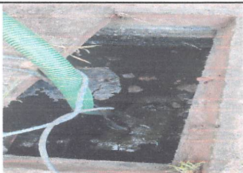
Foto #11: LIMPIEZA Y MANTENIMIENTO DE FOSA SÉPTICA
