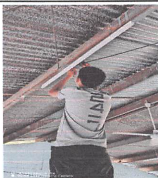
Foto #2: SUSTITUCIÓN DEL SISTEMA ELÉCTRICO
