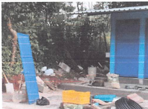
Foto #7: MANTENIMIENTO DE PUERTAS DE METAL
