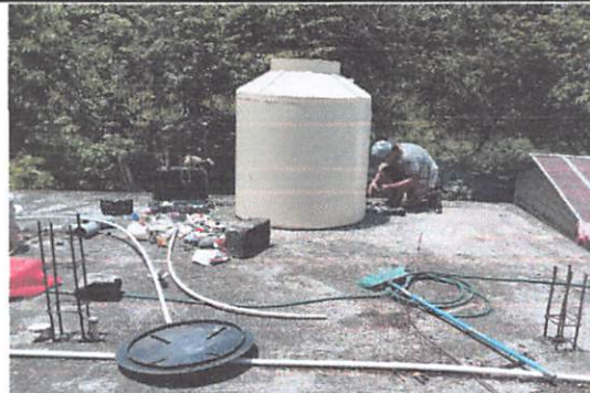
Foto #4: MANTENIMIENTO DE DEPÓSITO DE AGUA INCLUYE ACCESORIOS
