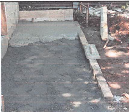
Foto #1: REPARACIÓN Y SUSTITUCIÓN DE PISO DE CONCRETO
