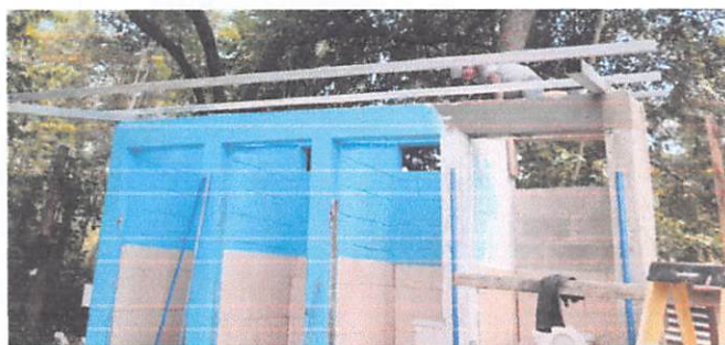
Foto #9: MANTENIMIENTO A ESTRUCTURA DE SOPORTE DE METAL CON ANTICORROSIVO
