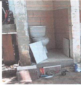
Foto #6: SUSTITUCIÓN DE PISO DE CONCRETO, POR CERÁMICO
