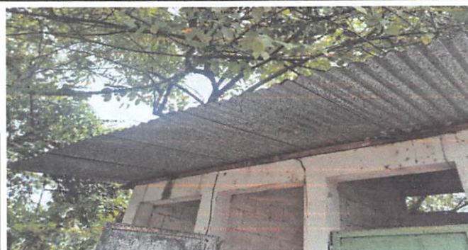
Foto #8: SUSTITUCIÓN DE LÁMINA, POR LÁMINA TROQUELADA CAL.26
