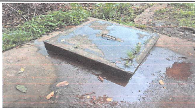
Foto #11: LIMPIEZA Y MANTENIMIENTO DE FOSA SÉPTICA
