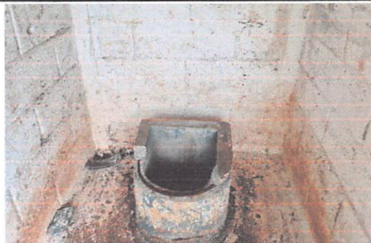
Foto #3: SUSTITUCIÓN DE SANITARIOS
