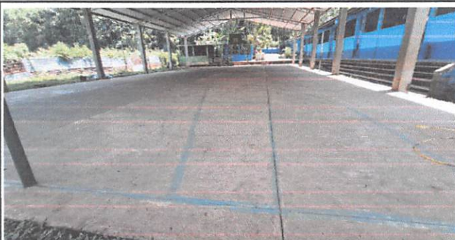
Foto #10: MANTENIMIENTO DE PISO DE CANCHA DEPORTIVA CON SUMINISTRO Y APLICACIÓN DE PINTURA EPÓXICA
