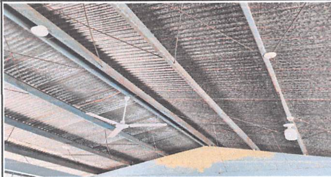
Foto #2: SUSTITUCIÓN DEL SISTEMA ELÉCTRICO
