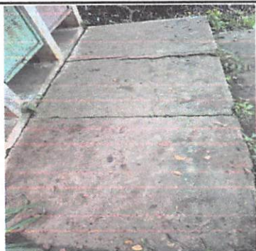
Foto #1: REPARACIÓN Y SUSTITUCIÓN DE PISO DE CONCRETO
