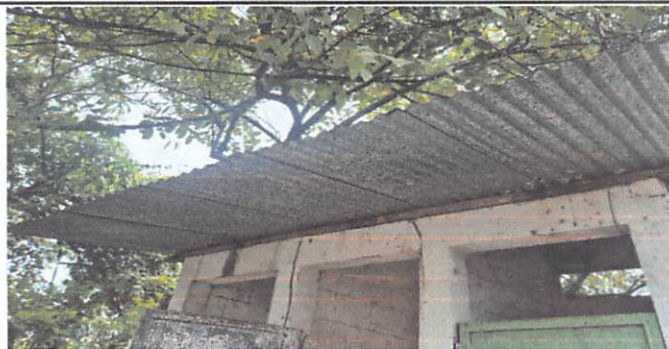
Foto #9: MANTENIMIENTO A ESTRUCTURA DE SOPORTE DE METAL CON ANTICORROSIVO
