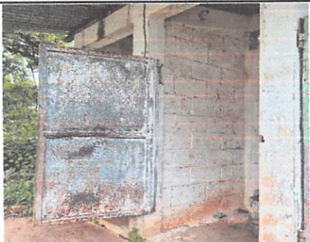
Foto #7: MANTENIMIENTO DE PUERTAS DE METAL
