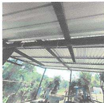
SUSTITUCION DE LAMINA, POR LAMINA TROQUELADA CAL 26
