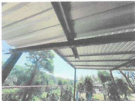
SUSTITUCIÓN DE ESTRUCTURA DE SOPORTE DE METAL POR METAL , SUSTITUCIÓN DE CANAL DE METAL
