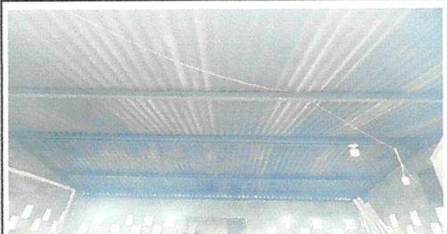
sustitución de lámina, por lámina troquelada calibre 26
