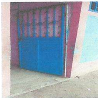
mantenimiento sustitución de puerta metalica
