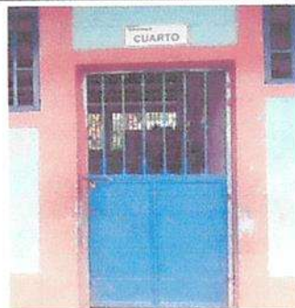
mantenimiento sustitución de puerta metalica
