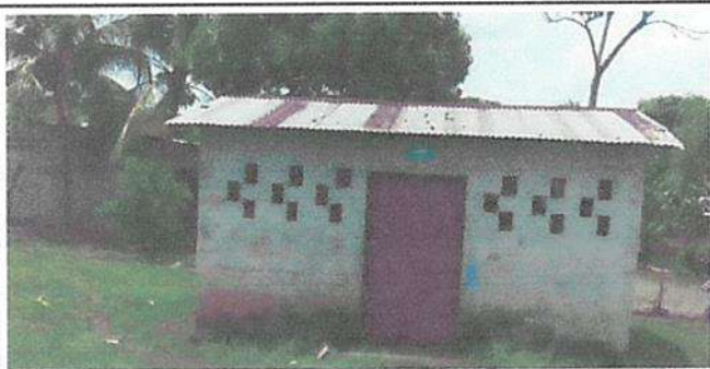
sustitución de lámina, por lámina troquelada calibre 26
