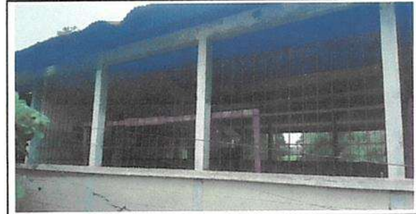
Sustitución de balcones de 1.85 por 2.35 metros
