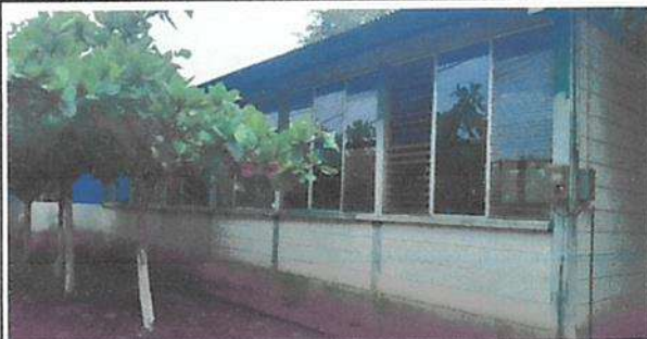
Sustitución de balcones de 1.40 por 2.35 metros , Sustitución de balcones de 1.20 por 1.35 metros
