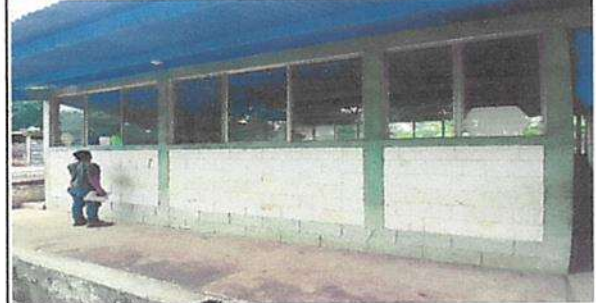
Sustitución de balcones de 1.85 por 2.35 metros
