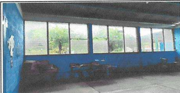
Sustitución de balcones de 1.85 por 2.35 metros
