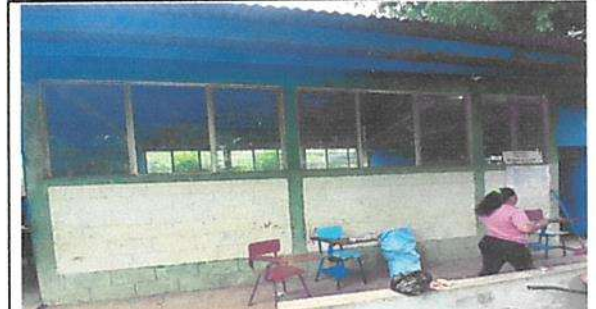
Sustitución de balcones de 1.85 por 2.35 metros
