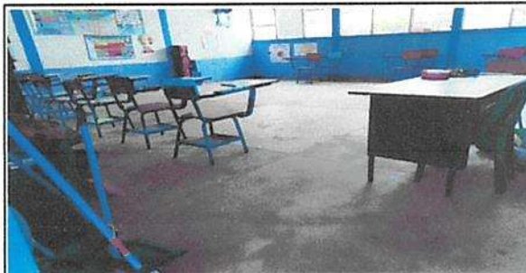
Sustitución de piso Ceramico Aula 4
