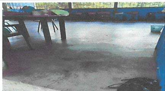
Sustitución de piso Ceramico Aula 1
