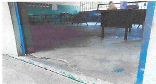
Sustitución de piso Ceramico Aula 2
