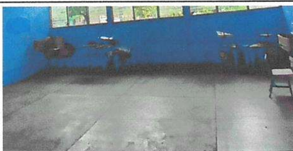
Sustitución de piso Ceramico Aula 3
