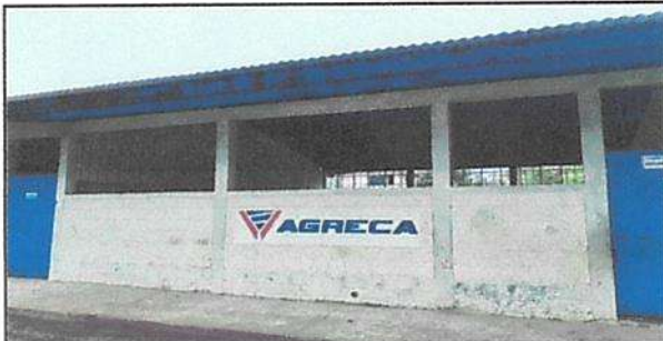
Sustitución de balcones de 1.85 por 2.35 metros
