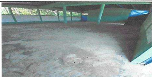
Sustitución de piso Ceramico Aula 5
