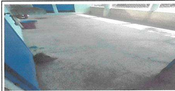
Pasillo del baño.
