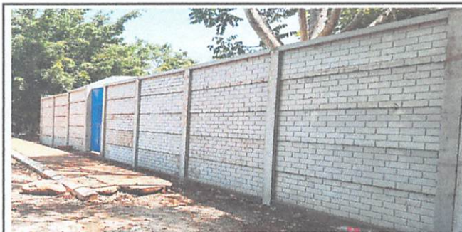
Foto 3: Sustrucción de muro perimetral, placa manual de 2.00*0.50*0.05 m tipo ladrillo, poste barda de 3.15*0.15*0.15 m tipo H reforzado
