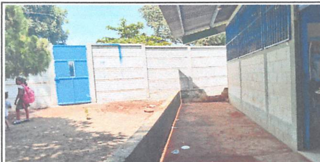
Foto 2: Sustrucción de muro perimetral, placa manual de 2.00*0.50*0.05 m tipo ladrillo, poste barda de 3.15*0.15*0.15 m tipo H reforzado
