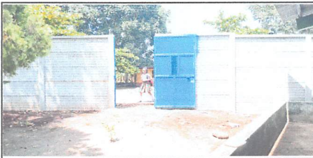
Foto 6: Sustrucción de muro perimetral, placa manual de 2.00*0.50*0.05 m tipo ladrillo, poste barda de 3.15*0.15*0.15 m tipo H reforzado
