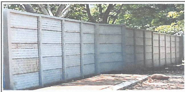
Foto 5: Sustrucción de muro perimetral, placa manual de 2.00*0.50*0.05 m tipo ladrillo, poste barda de 3.15*0.15*0.15 m tipo H reforzado
