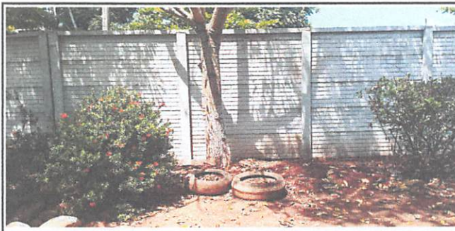
Foto 4: Sustrucción de muro perimetral, placa manual de 2.00*0.50*0.05 m tipo ladrillo, poste barda de 3.15*0.15*0.15 m tipo H reforzado
