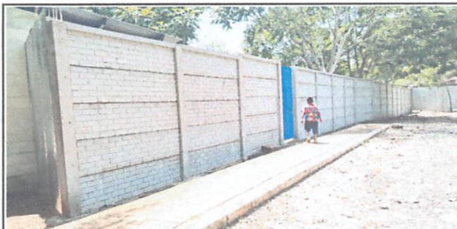
Foto 1: Sustrucción de muro perimetral, placa manual de 2.00*0.50*0.05 m tipo ladrillo, poste barda de 3.15*0.15*0.15 m tipo H reforzado
