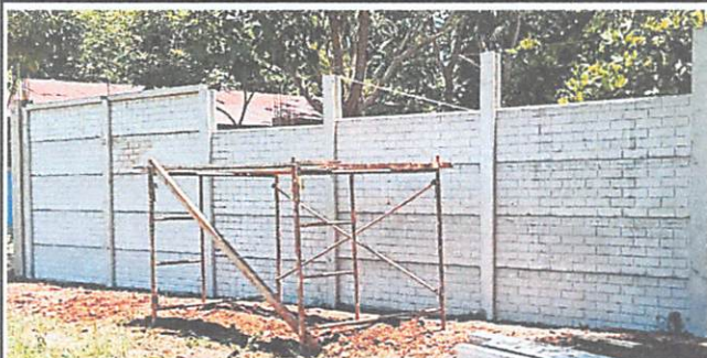
Foto 3: Sustitución de muro perimetral, placa manual de 2.00*0.50*0.05 m tipo ladrillo, poste barda de 3.15*0.15*0.15 m tipo H reforzado
