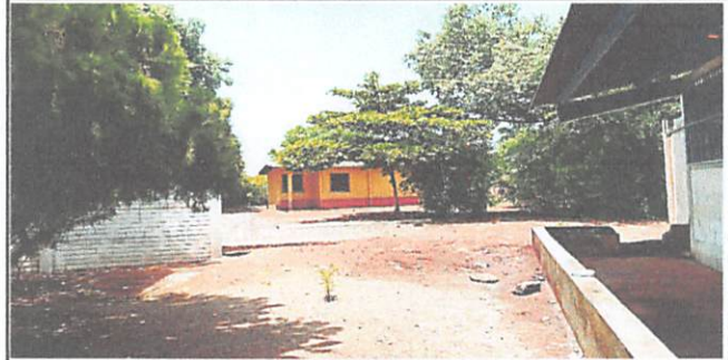
Foto 2: Sustitución de muro perimetral, placa manual de 2.00*0.50*0.05 m tipo ladrillo, poste barda de 3.15*0.15*0.15 m tipo H reforzado
