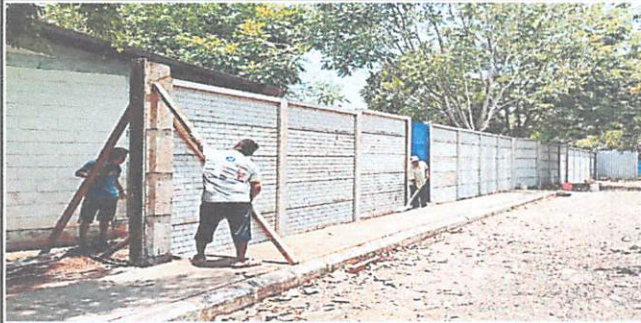
Foto 1: Sustitución de muro perimetral, placa manual de 2.00*0.50*0.05 m tipo ladrillo, poste barda de 3.15*0.15*0.15 m tipo H reforzado
