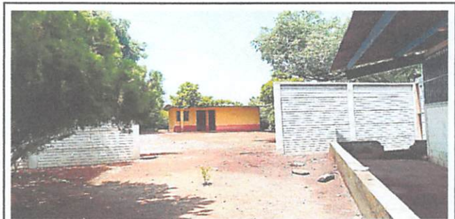
Foto 6: Sustitución de muro perimetral, placa manual de 2.00*0.50*0.05 m tipo ladrillo, poste barda de 3.15*0.15*0.15 m tipo H reforzado
