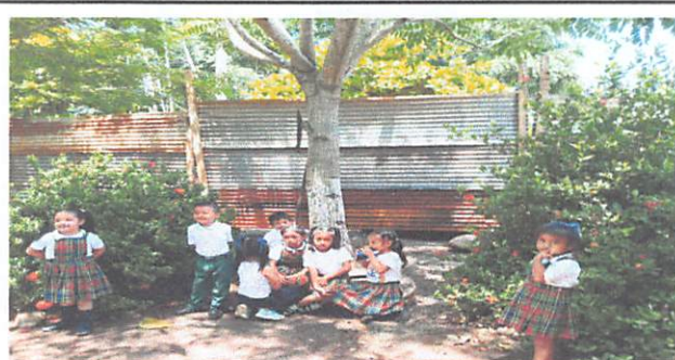
Foto 4: Sustitución de muro perimetral, placa manual de 2.00*0.50*0.05 m tipo ladrillo, poste barda de 3.15*0.15*0.15 m tipo H reforzado
