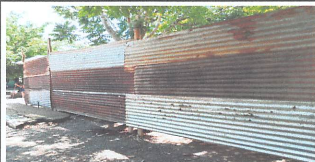
Foto 3: Sustitución de muro perimetral, placa manual de 2.00*0.50*0.05 m tipo ladrillo, poste barda de 3.15*0.15*0.15 m tipo H reforzado
