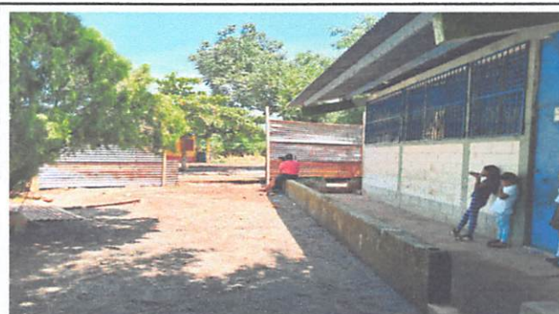
Foto 2: Sustitución de muro perimetral, placa manual de 2.00*0.50*0.05 m tipo ladrillo, poste barda de 3.15*0.15*0.15 m tipo H reforzado
