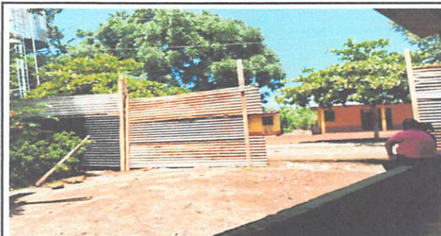
Foto 6: Sustitución de muro perimetral, placa manual de 2.00*0.50*0.05 m tipo ladrillo, poste barda de 3.15*0.15*0.15 m tipo H reforzado
