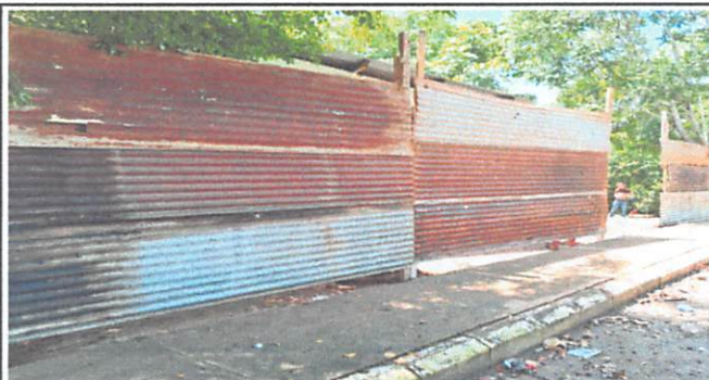
Foto 1: Sustitución de muro perimetral, placa manual de 2.00*0.50*0.05 m tipo ladrillo, poste barda de 3.15*0.15*0.15 m tipo H reforzado
