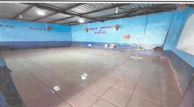
FOTO 3: Sustitución de piso de concreto por piso cerámico 88 M2 en aula 1
