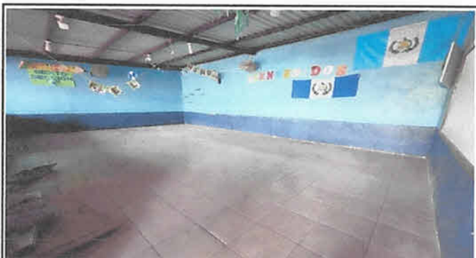
FOTO 4: Sustitución de piso de concreto por piso cerámico 88 M2 en aula 2
