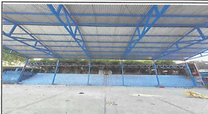
FOTO 2: Sustitución de piso de concreto por piso cerámico antideslizante en gradas 201 M2
