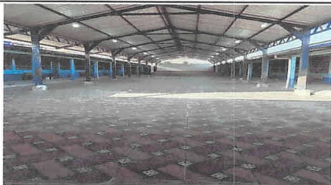
FOTO 1: Sustitución de piso de concreto por piso cerámico antideslizante patio del escenario 380 M2
