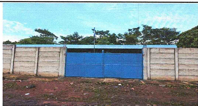
FOTOGRAFIA 3. SUMINISTRO Y SUSTITUCION DE PORTON METALICO 4.25X 2.00 METROS, PUERTA CENTRAL, CON CHAPA YALE, PINTURA ANTICORROSIVA COLOR AZUL
