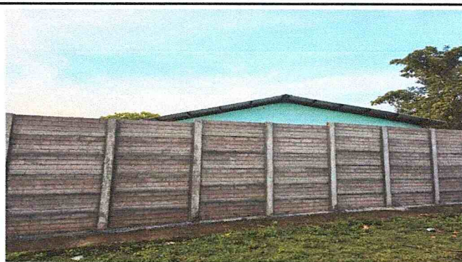
FOTOGRAFIA 2. SUSTITUCIÓN DE MURO PERIMETRAL CON BARDA PREFABRICADA DE CONCRETO H=2.50 M (CONCRETO REFORZADO) 252 METROS CUADRADOS
