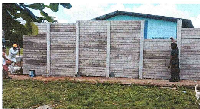
FOTOGRAFIA 2. SUSTITUCIÓN DE MURO PERIMETRAL CON BARDA PREFABRICADA DE CONCRETO H=2.50 M (CONCRETO REFORZADO) 252 METROS CUADRADOS
