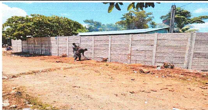
FOTOGRAFIA 1. SUSTITUCIÓN DE MURO PERIMETRAL CON BARDA PREFABRICADA DE CONCRETO H=2.50 M (CONCRETO REFORZADO) 252 METROS CUADRADOS.
