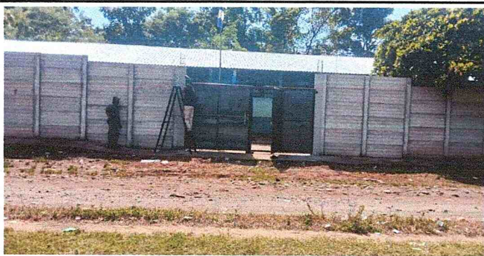
FOTOGRAFIA 3. SUMINISTRO Y SUSTITUCION DE PORTON METALICO 4.25X 2.00 METROS, PUERTA CENTRAL, CON CHAPA YALE, PINTURA ANTICORROSIVA COLOR AZUL
