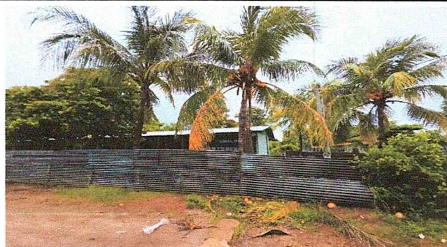
FOTOGRAFIA 1. SUSTITUCIÓN DE MURO PERIMETRAL CON BARDA PREFABRICADA DE CONCRETO H=2.50 M (CONCRETO REFORZADO) 252 METROS CUADRADOS.
